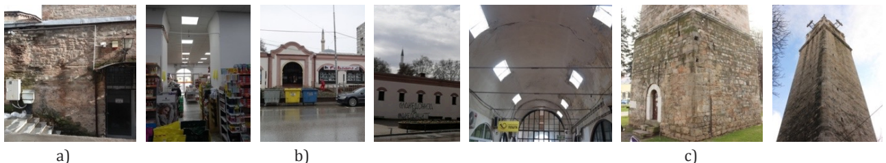
Şekil 14. Hamam(a), Arasta Çarşısı (b) ve Saat Kulesi (c) gözlemlenen hasarlar ve günümüzdeki durumları (Maksud, 2024).
